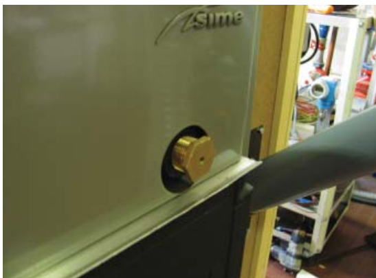
Εικ. 27 Ορειχάλκινος μειωτήρας
