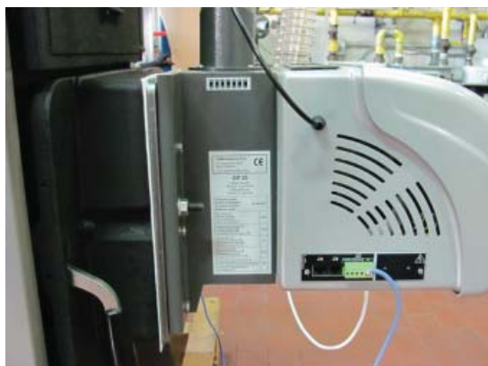
Εικ. 26 Στερέωση καυστήρα
