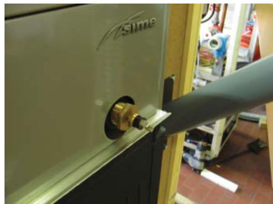
Рис. 28 Предохранительный термостат
