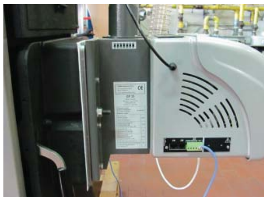
Рис. 26 Крепеж горелки
