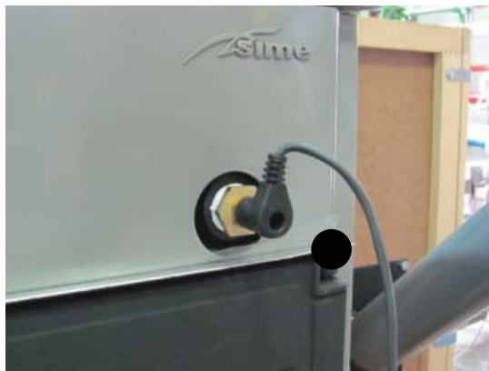
Εικ. 34 Συνδετήρας θερμοστάτη ασφαλείας
