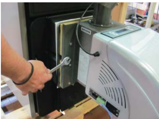
Εικ. 25 Τοποθέτηση καυστήρα
