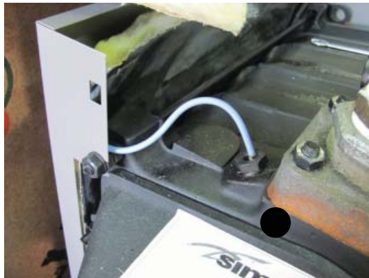
Εικ. 36 Αισθητήρας παροχής
