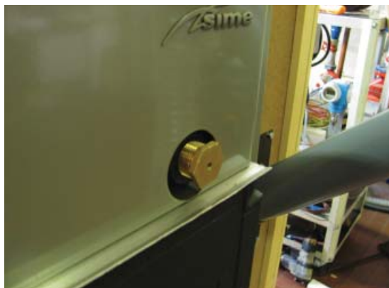
Рис. 27 Латунный редуктор
