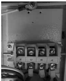
Рис.5 Подключение котла к электросети.
