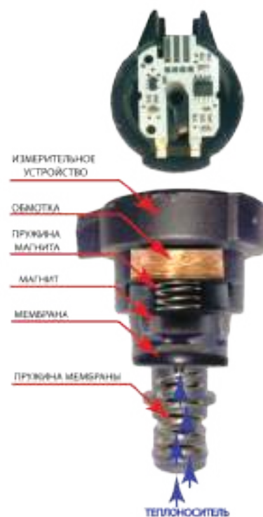
Рис. 10 Датчик минимального давления в системе отопления
